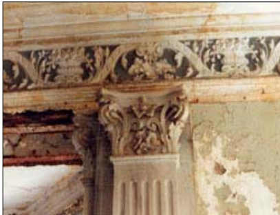
Resim 4. 62 Düzenlemelerin yangın öncesi durumu (Akin
