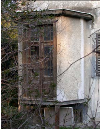
Resim 5.2 Kapalı çıkma elemanı ,Steinbüchel köşkü-Bornova
