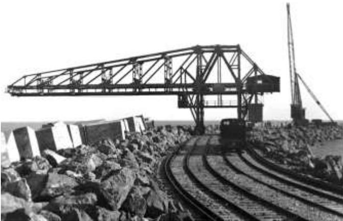
La grue transporteuse pour blocs de 50 tonnes, et un derrick
